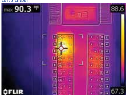
Bereichsfeld mit Hot-Spot-Anzeige macht aktive elektrische Sicherung sichtbar
