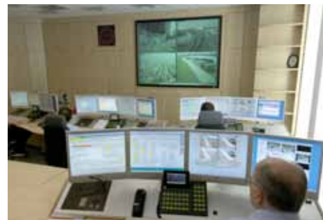
Der BASF-Kontrollraum ist das Zentrum des Sicherheitsnetzwerks, wo alle Aufzeichnungen der Tag-Nacht- sowie der Wärmebildkameras analysiert werden.
